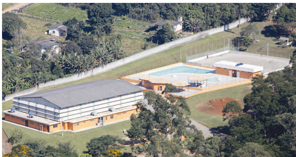
PROPRIEDADE: Imagem aérea mostra o Sítio com sua pintura recente. Local é cercado de grande área verde preservada
