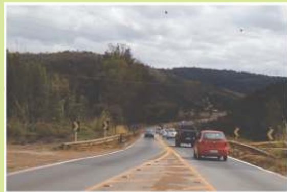
Estreitamento de pista provocado por viadutos antigos
